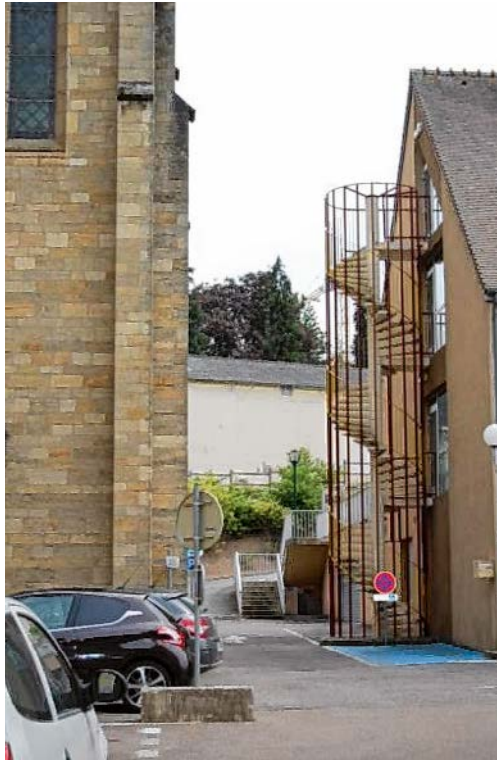
Abb. 5: Beispiel einer für denkmal- geschützte Gebäude ungeeig- neten Fluchttreppe (2014).
