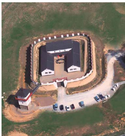
Abb. 8: Limeskastell Pohl (Rhein-Lahn-Kreis), Luftbild der Anlage.
