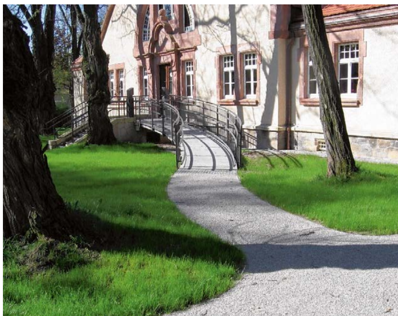
Abb. 2: Chemnitz-Altendorf, ehemalige Landesblindenanstalt, neuer barrierefreier Zugang als Rampe, angemessene Möglichkeit.
