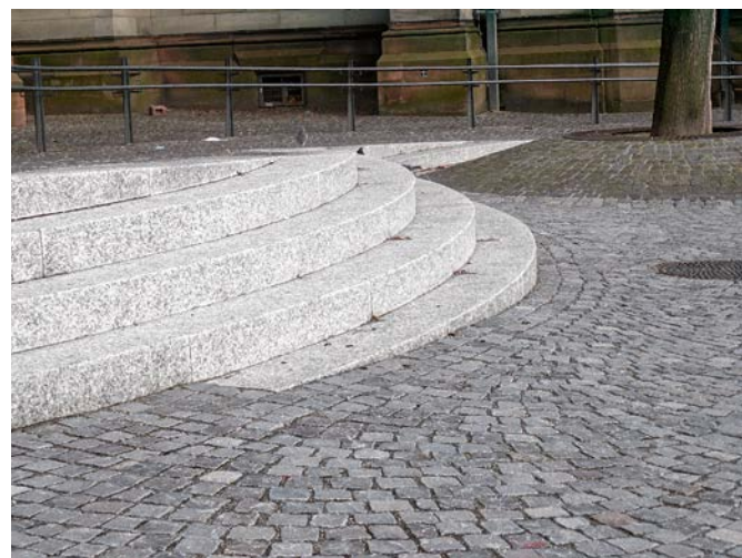
Abb. 10: Gedächtniskirche Speyer, Detail Treppe mit schiefer Ebene.
