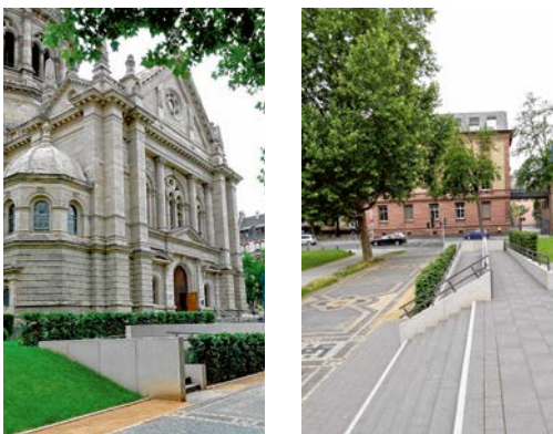
Abb. 3: Christuskirche Mainz, Ansicht vom Norden 1. Rampenlauf.
