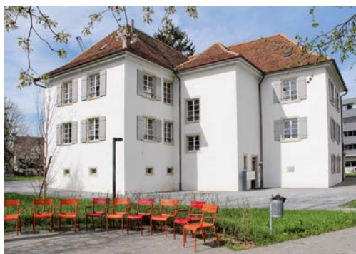
Abb. 14: Möhlin, Villa Kym, neuer Haupteingang nach Umbau und Restaurierung; Architekt: Castor Huser, Baden; Landschaftsarchitekt: Christoph Burger, Rombach.
